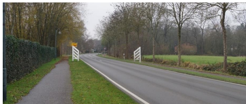
Abbildung 27: Kaltenkirchener Straße Richtung Kaltenkirchen 29
